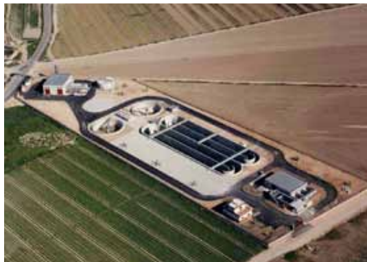
Fig. 2.11 EDAR de Torre Pacheco (ESAMUR)
