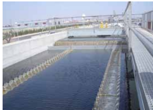
Fig. 2.16 Vista de la depuradora de Torre Pacheco ESAMUR
