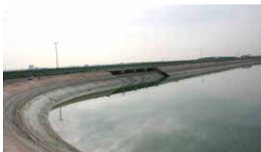
Fig. 4.10 Embalse regulador de la CRCC en la Impulsión de Fuente Álamo
