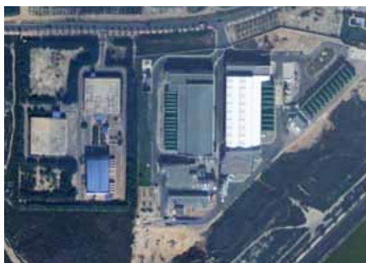
Fig. 2.18 Vista plantas desaladoras CRCC y CHS (San Pedro del Pinatar I y II)
