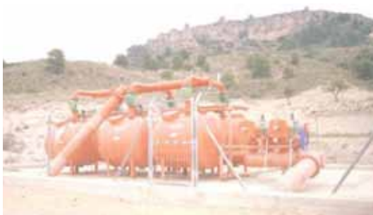
Fig. 5.8a Cabezal de riego por goteo (Regadíos de Mula-Murcia)
