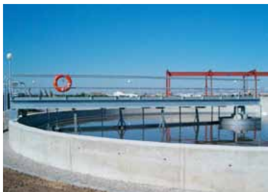
Fig. 2.13 Decantador de la EDAR de Torre Pacheco
