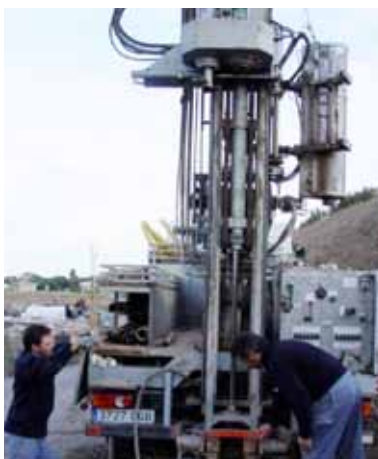
Fig. 4.18 Realización de un sondeo para el seguimiento del nivel freático
